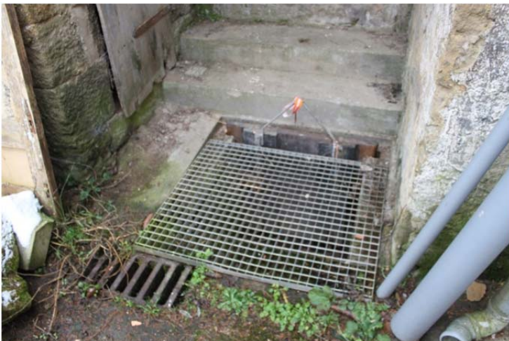
Bild 38: Offener Schacht in der Wassergasse
