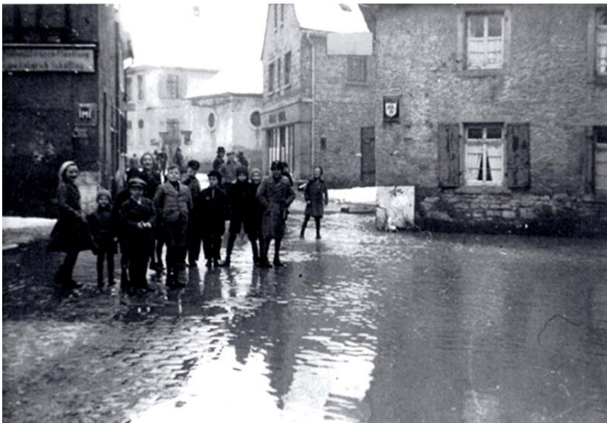
Bild 1: Hochwasser in der Hauptstraße (Jahr unbekannt)
