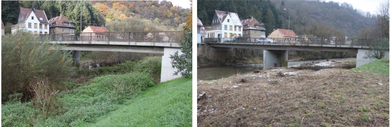
Bild 8: Neue Brücke über den Glan 2014 vor und nach der Rodung
