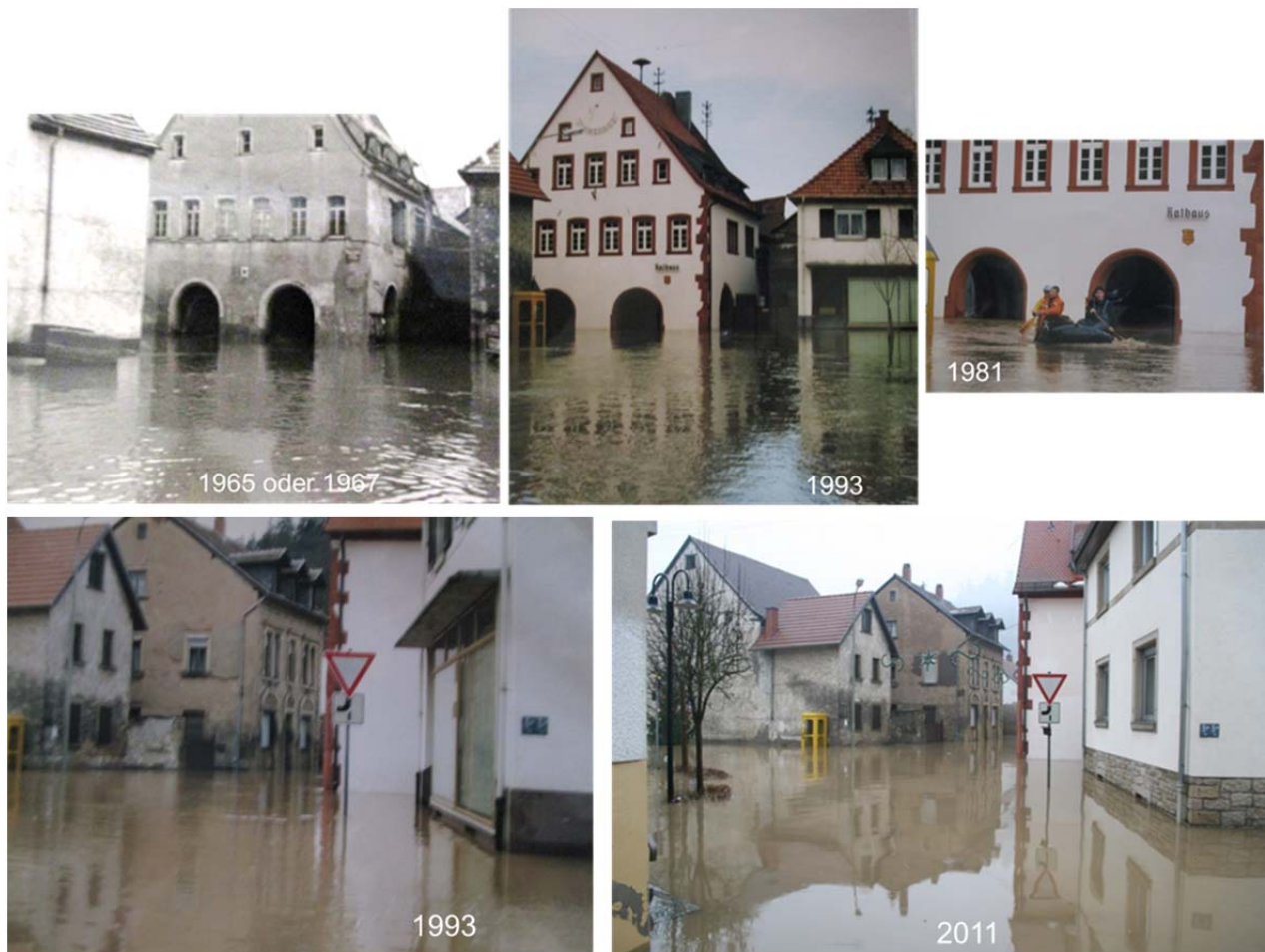
Bild 28: Überflutungssituationen bei früheren Hochwassern in der Hauptstraße im Bereich Rathaus
