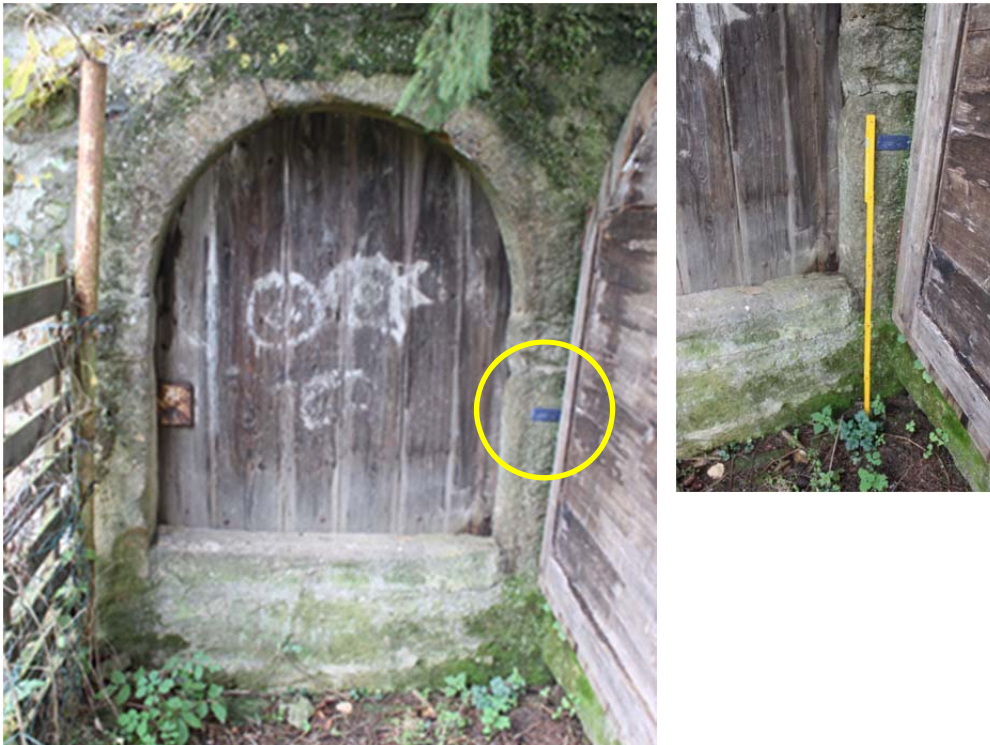
Bild 41: Hochwassermarken von 1981 in der Wassergasse
