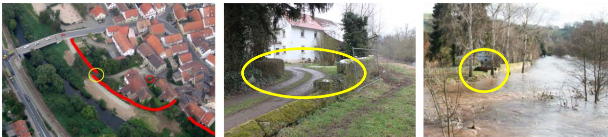
Bild 14: Mobiler Hochwasserschutz in der Zufahrt zur ehemaligen Mühle vom Glan her
