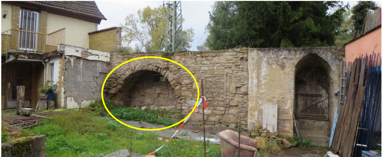
Bild 34: Ringmauer in der Wassergasse
