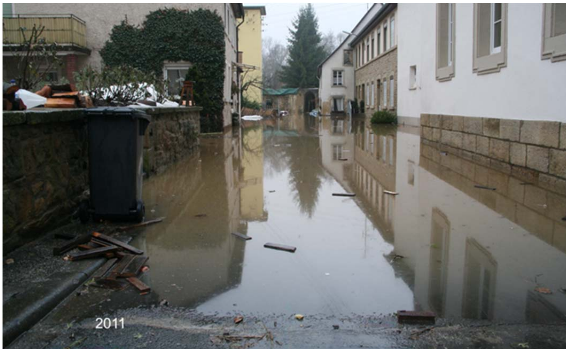
Bild 42: Hochwasser in der Wassergasse bei gefallenem Glanpegelstand
