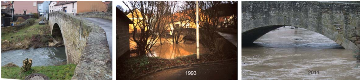
Bild 45: Überflutung des Odenbachs unterhalb Straße „Waldweg“
