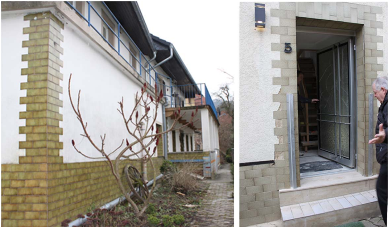
Bild 36: Private Objektschutzmaßnahmen in der Wassergasse
